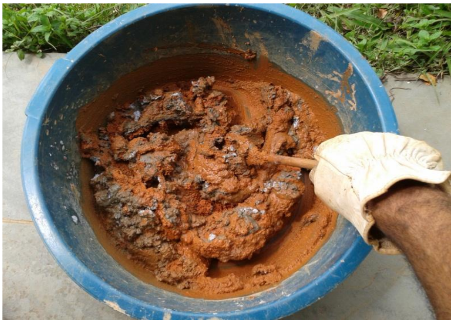
Figura 6: Terra seca e areia fina peneiradas, cimento peneirado e pasta de papel sendo misturados.
