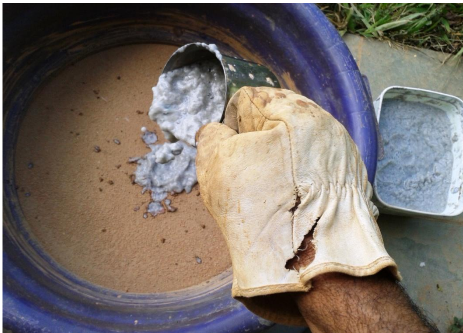
Figura 5: Pasta de papel sendo misturada à mistura de terra seca e areia fina peneiradas e cimento peneirado.
